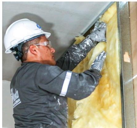
Coloca el aislante de fibra de vidrio dentro de los muros para mantener un mejor aislamiento térmico-acústico.
