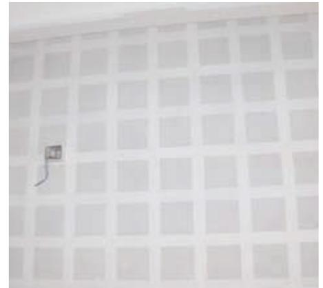
Fijar los tornillos yeso-metal 26 de 1" @30cm máximo en muros y @ 20 cms máximo en plafones.
