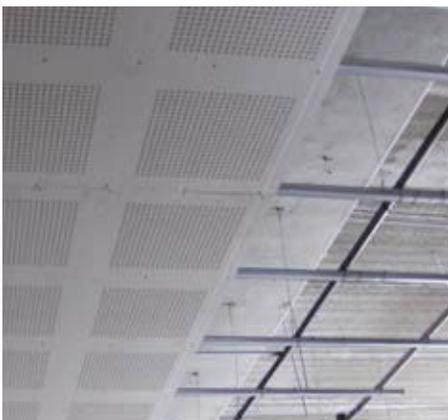
El armado de la estructura para los plafones es igual que el sistema de placa de yeso estándar, la única diferencia es la separación del canal listón el cual deberá ir @60cm.
